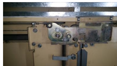
Serrure de porte palière du niveau principal
